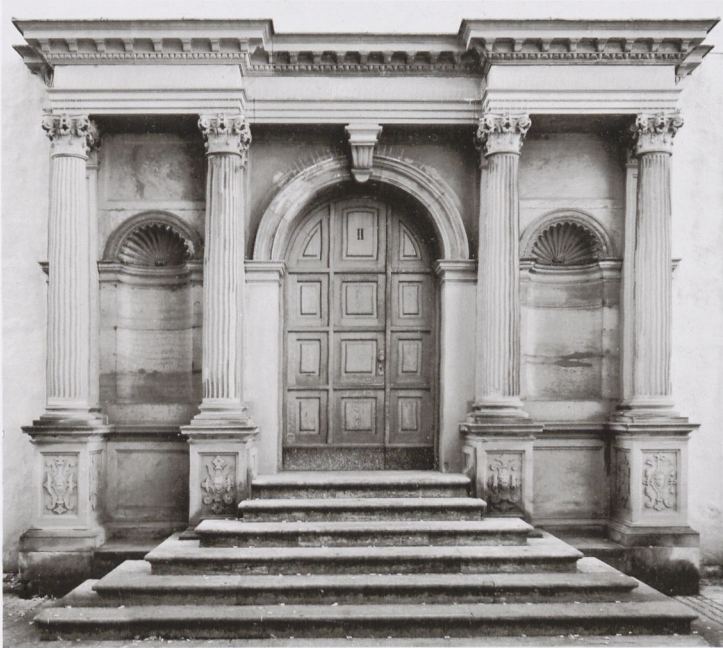
Abb. 2 Würzburg, Alte Universität, Nordflügel, mittleres Portal
