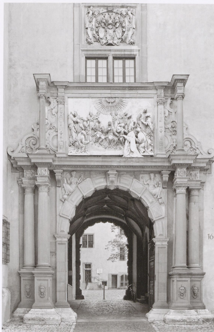
Abb. 1 Würzburg, Alte Universität, Nordflügel, Hauptportal
