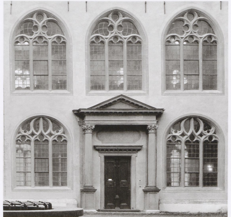
Abb. 1 Würzburg, Alte Universität, Nordflügel, Maßwerkfenster und Portal der Neubaukirche
