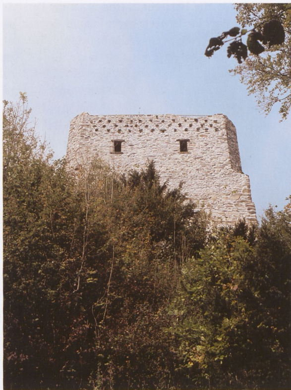
Abb. 11 Ringgenberg, Südfassade mit Nischen.
