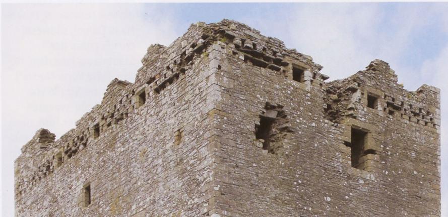
Abb. 18 Threave Castle (Scotland, Co. Dumfries and Galloway), der obere Teil des Keep von Südwesten. Auf Höhe eines Halbgeschosses dicht unter den Zinnen sind drei gegeneinander versetzte Reihen von Nistlöchern angeordnet.
