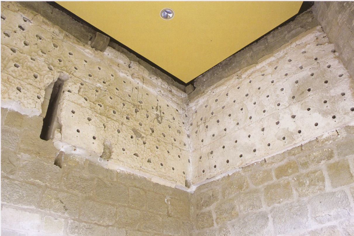
Abb. 20 Olite (Spanien, Prov. Navarra), kleine Nistlöcher für Ziervögel in der „Patio de la Pajarera“ (Voliere); die Löcher für die früheren Sitzstangen sind unter jedem Loch sichtbar.
