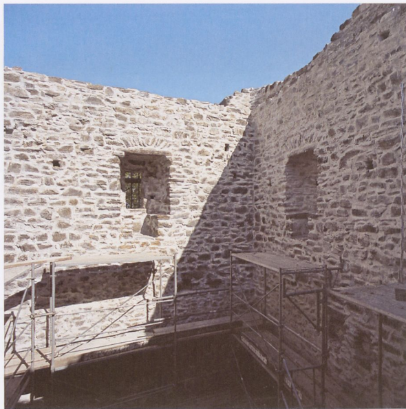
Abb. 8 Ringgenberg, Blick ins Saalgeschoss mit zwei Fenster­nischen, Blick nach Südost.
