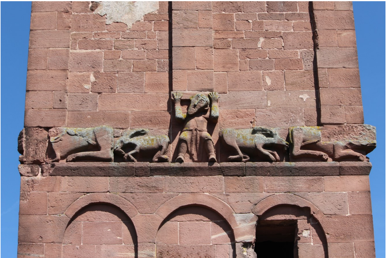
Abb. 5: Figurenfries am Eulenturm, Südseite
