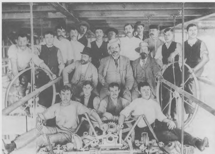
60. Jan Zawiejski w trakcie robót wykończeniowych przy budowie Teatru Miejskiego, 1893.
