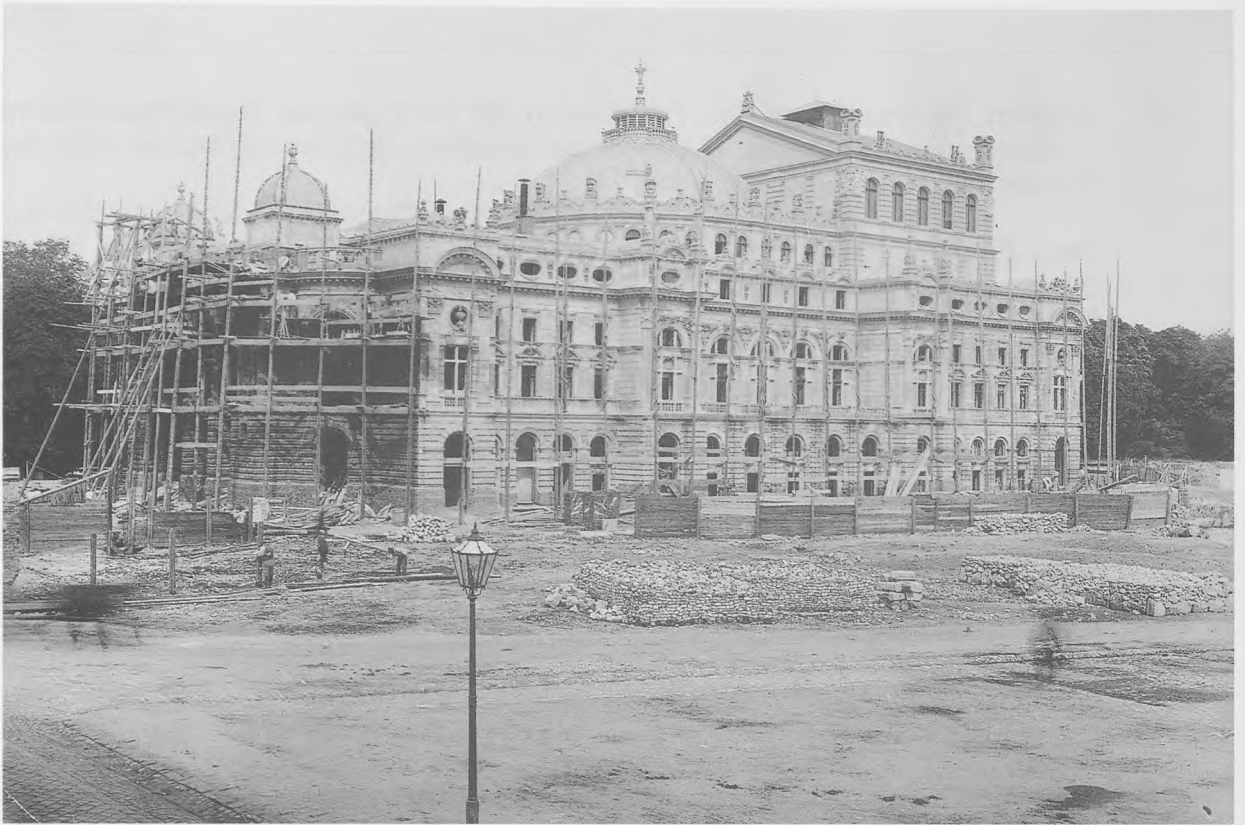
61. Teatr w trakcie prac budowlanych, 1893.
