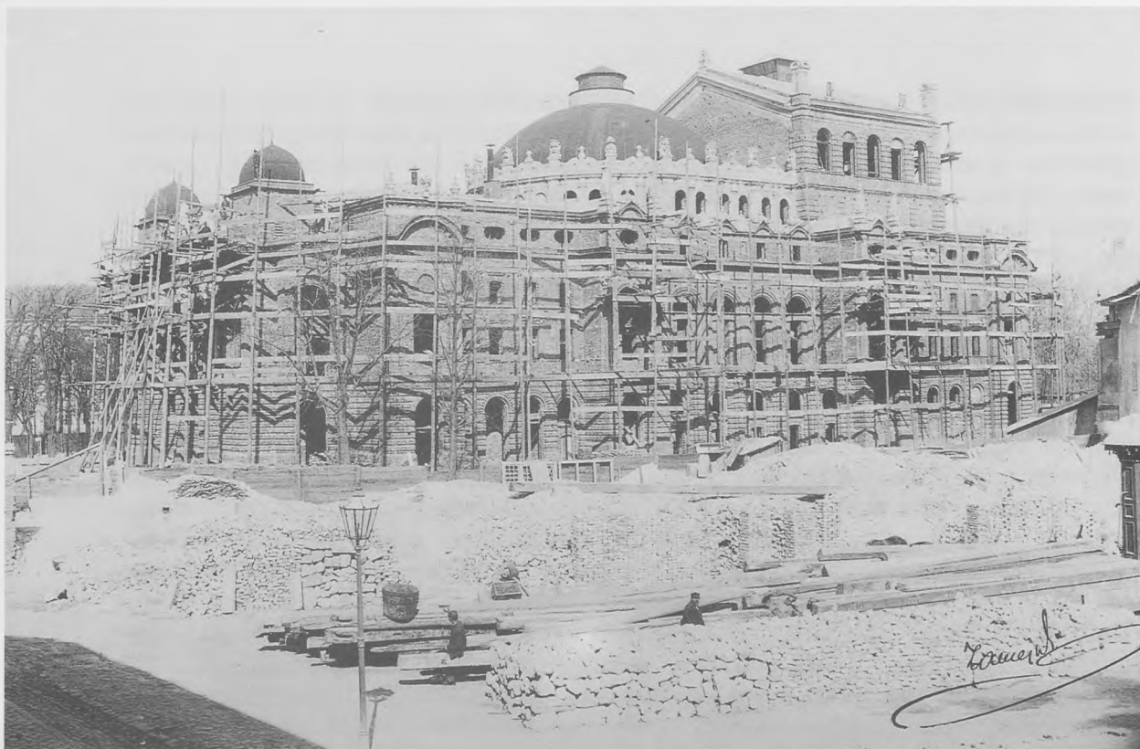
59. Budowa Teatru Miejskiego w Krakowie, 1892. Na pierwszym planie rozbiórka zabudowań poduchackich.
