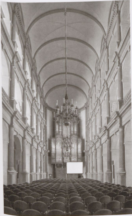
Abb. 2: Würzburg, Universitätskirche, Neubaukirche heute ohne Schlingrippenwölbung im Mittelschiff; der Raum war einst von einem gold- und buntfarbigem Rippenwerk überspannt, 1582–1591
