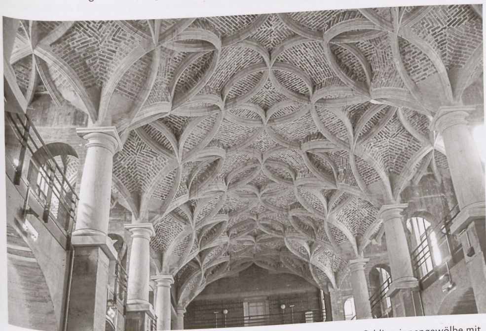
Abb. 8: Dresden, Schlosskapelle, zwischen 2009 und 2013 wiederhergestelltes Schlingrippengewölbe mit Sandsteinrippen und Backsteinkappen
