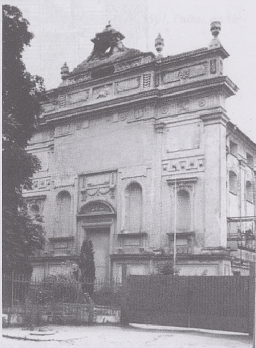
Il. 12. Krakowiec, kościół parafialny, fasada, fot. S. Michta, 1995.
