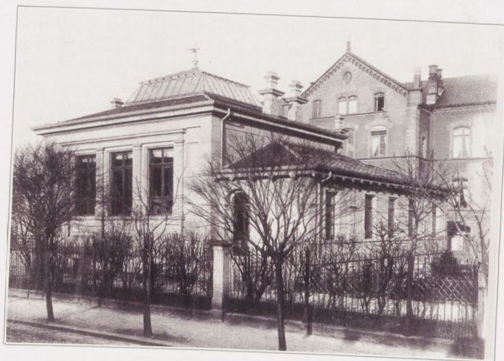
Hörsaalgebäude Voßstraße vor 1900 (Quelle: Universitätsbauamt Heidelberg)
