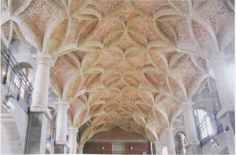
Abb. 8: Schlosskapelle Dresden, Rohbau/Wiederaufbau der ehem. Schlosskapelle mit rekonstruierten Schlingrippengewölbe
