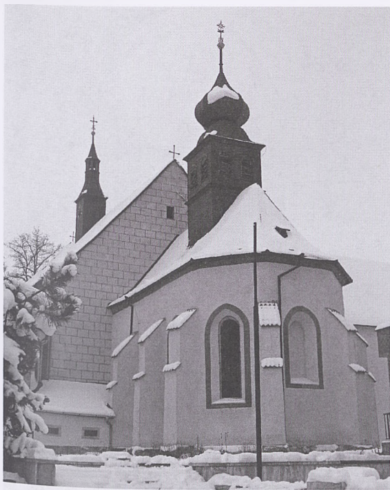
8. Jindřichovy Gródek, kościoła bernardynów, prezbiterium zbudowane w r. 1619.
