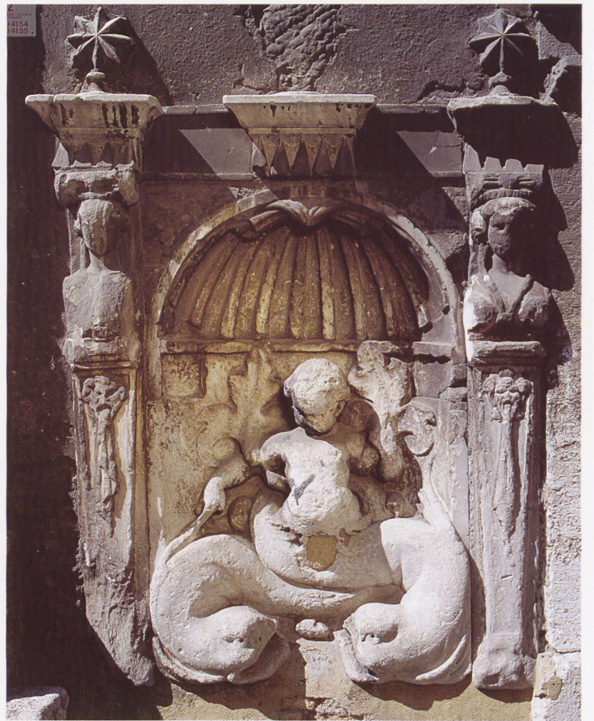
La fontana sulla facciata.
