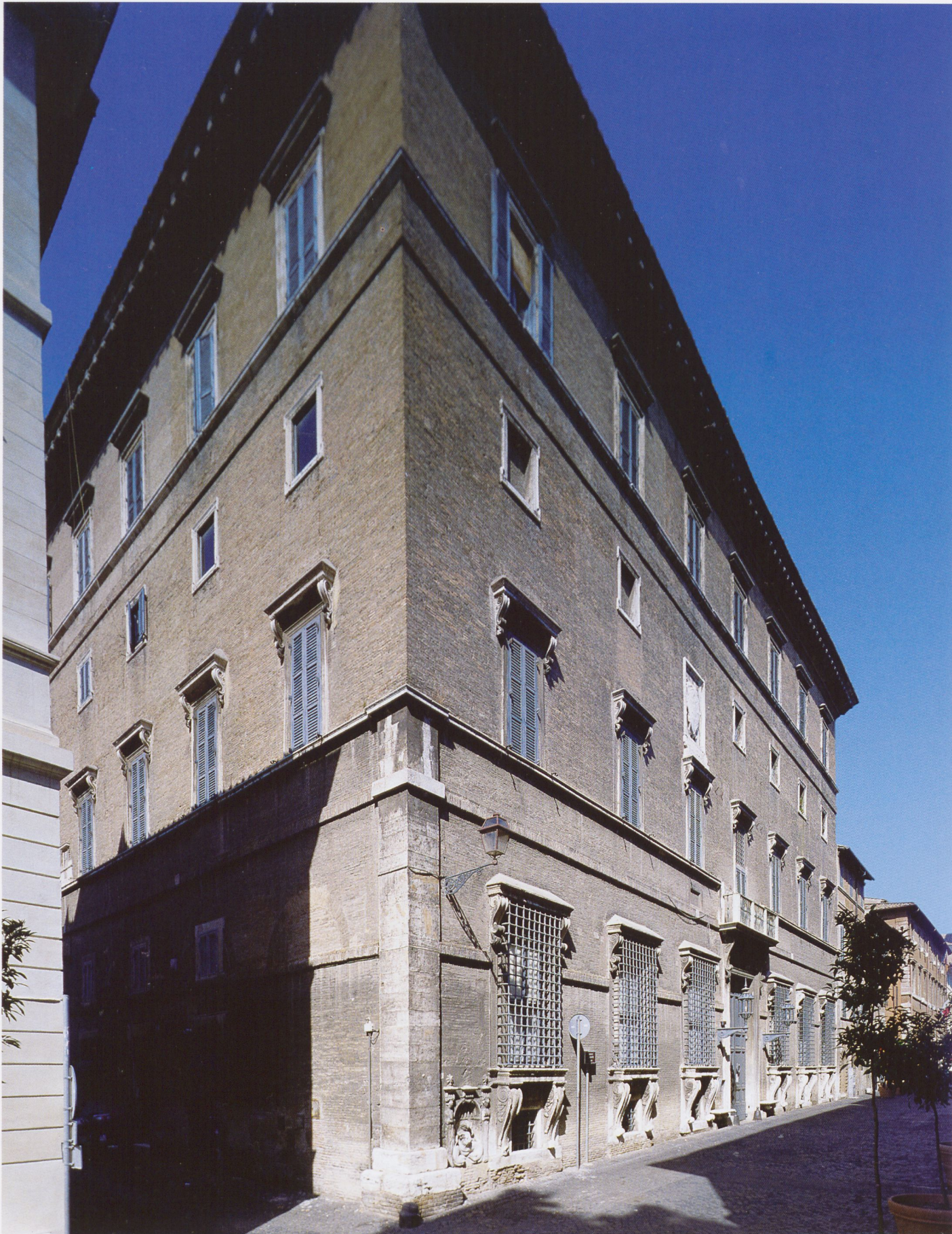
Palazzo Sacchetti. La facciata su via Giulia e fianco su vicolo del Cefalo.
