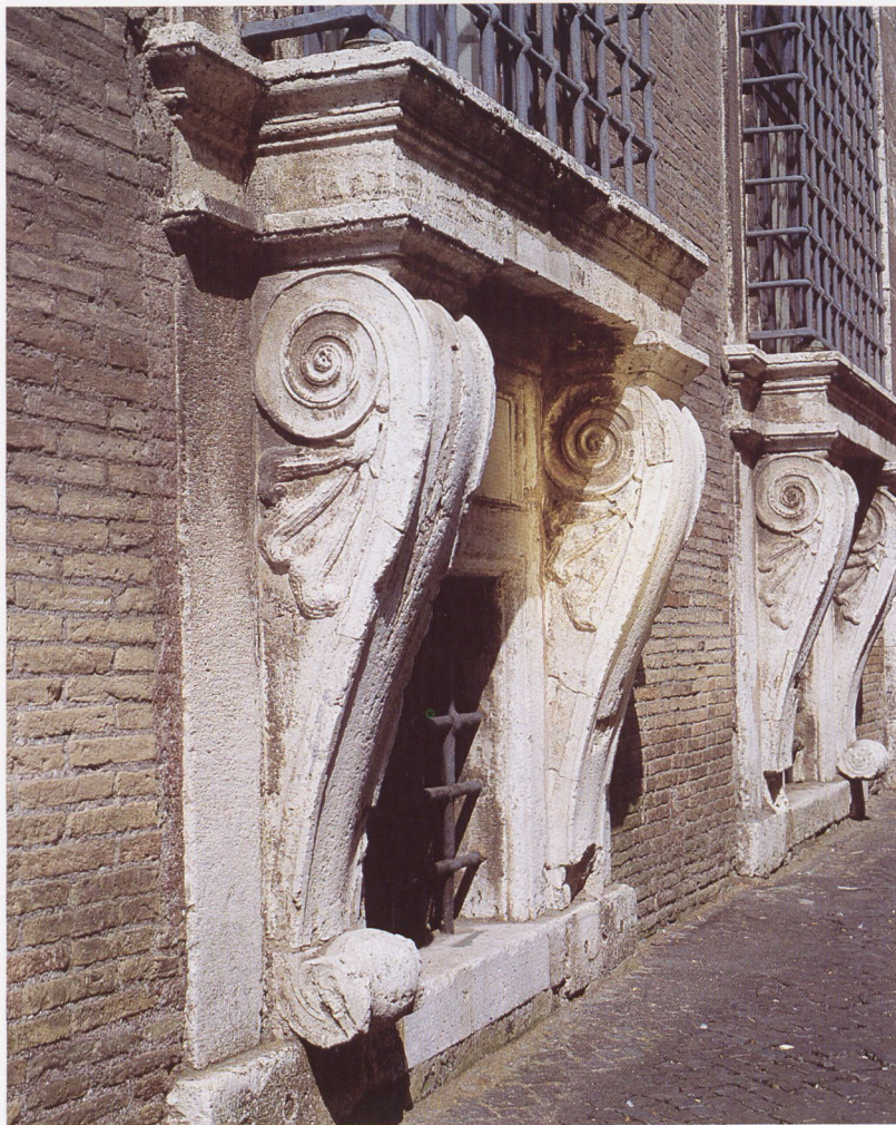
Mensole delle finestre del piano terreno.
