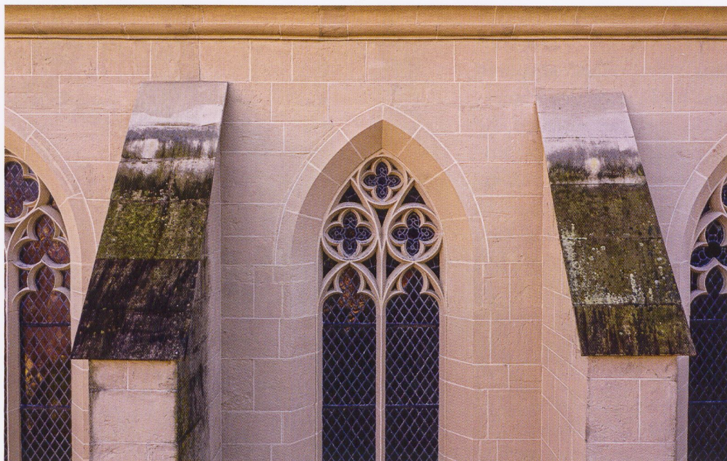
Abb. 15 Dominikanerkirche Bad Wimpfen, Strebpfeiler und Maßwerkfenster der Chornordseite
