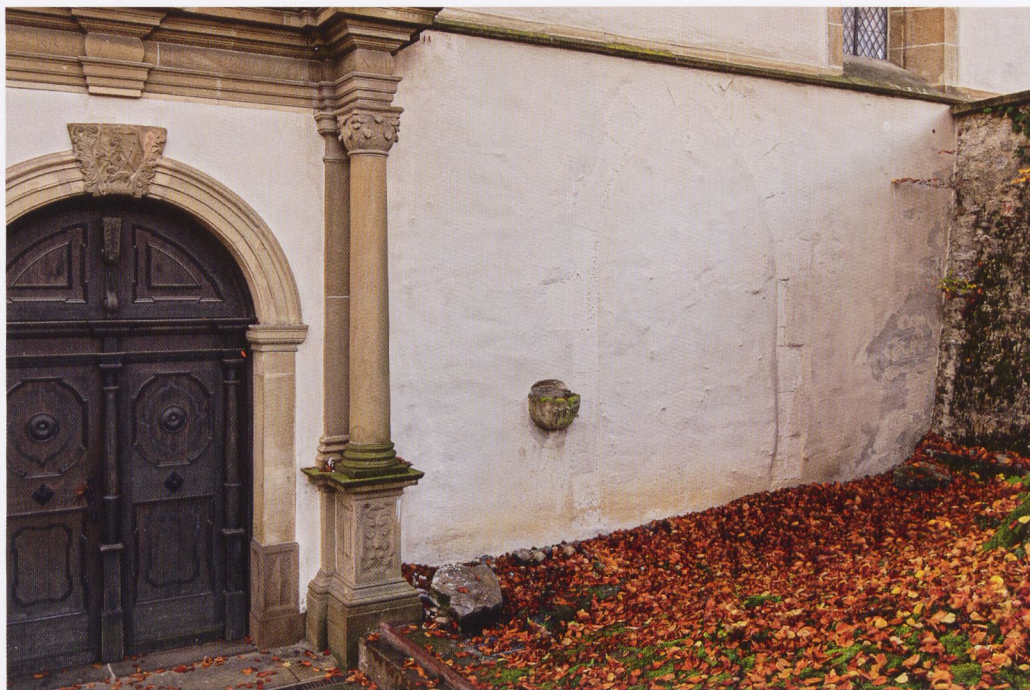
Abb. 19 Dominikanerkirche Bad Wimpfen, Langhausnordseite, zugesetztes Portal
