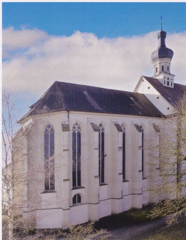
Abb. 13 Dominikanerkirche Bad Wimpfen, Strebebögen und Maßwerkfenster der Chornordseite
