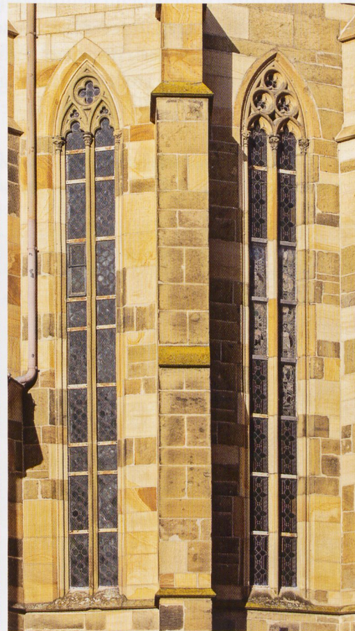
Abb. 44 links Stiftskirche St. Peter Bad Wimpfen im Tal, Maßwerkfenster mit Passform über Nonnenköpfchen
