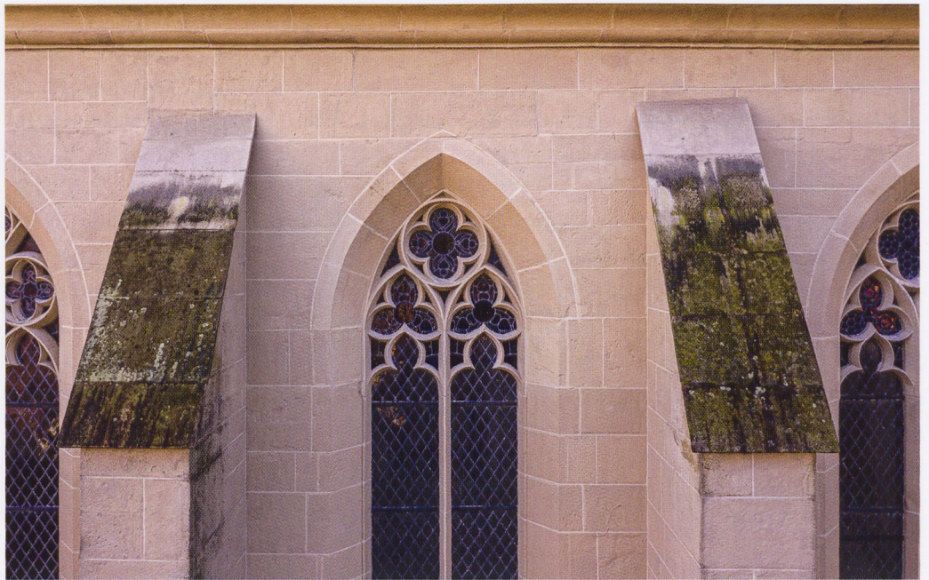
Abb. 14 Dominikanerkirche Bad Wimpfen, Strebepfeiler und Maßwerkfenster der Chornordseite
