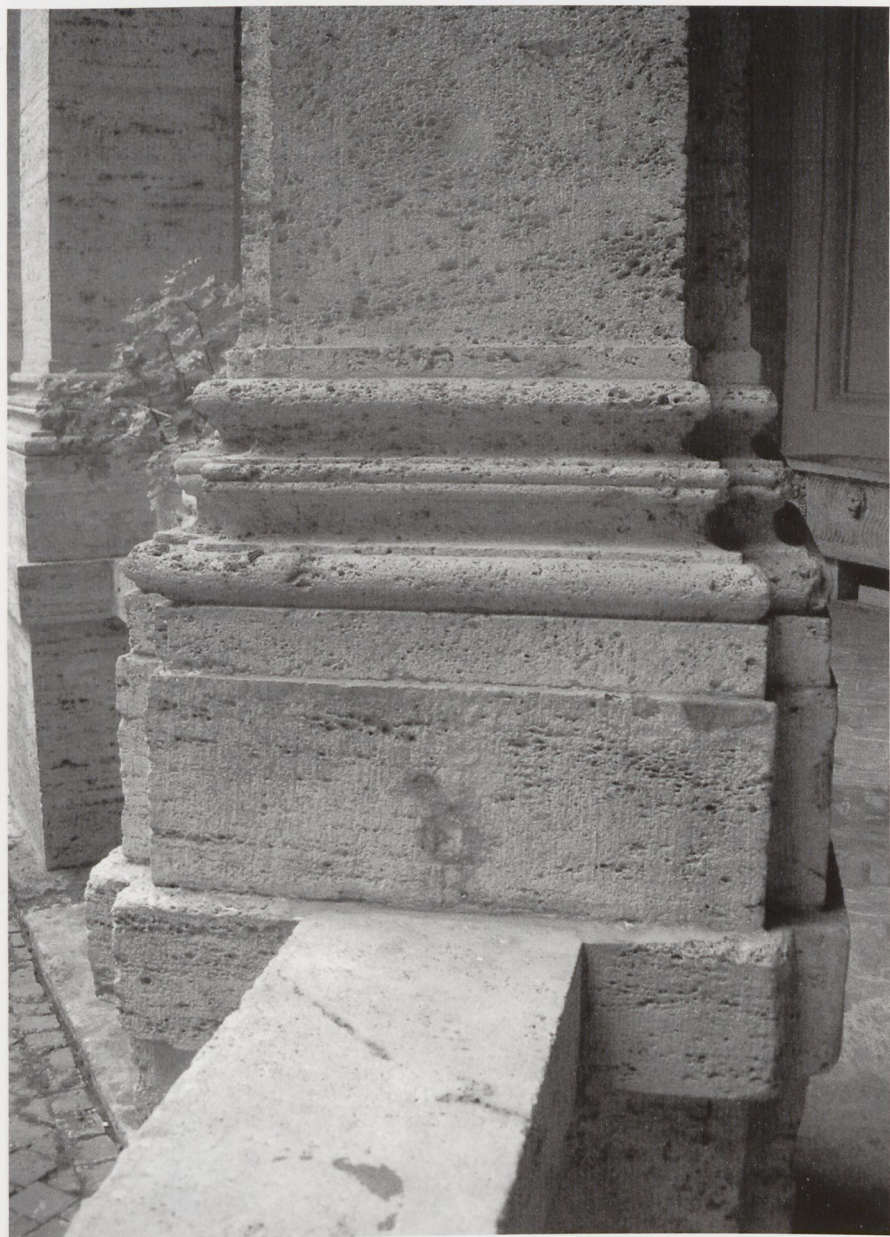
23 - Roma, palazzina di Pio IV, piedistallo del portico del cortile con base
