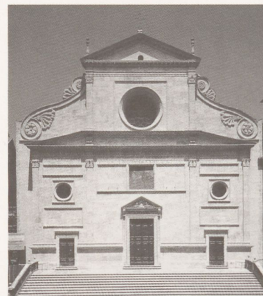
Jacopo da Pietrasanta, facciata della chiesa di Sant'Agostino, Roma.
