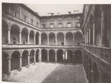
Cortile del palazzo della Cancelleria, Roma.
