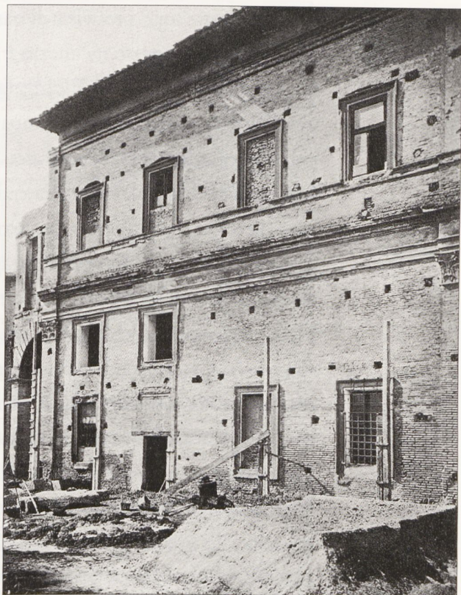
16. Facciata orientale della palazzina, prima dei lavori di restauro promossi da Ugo Jandolo. Da JANDOLO 1923, p. 74. Nella fotografia sono visibili le aperture per i ponteggi dei muratori, in quanto l'edificio cinquecentesco è rimasto incompiuto fino agli inizi del Novecento.
