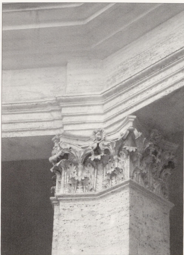
22. Capitello e trabeazione visti dall'interno del portico.
