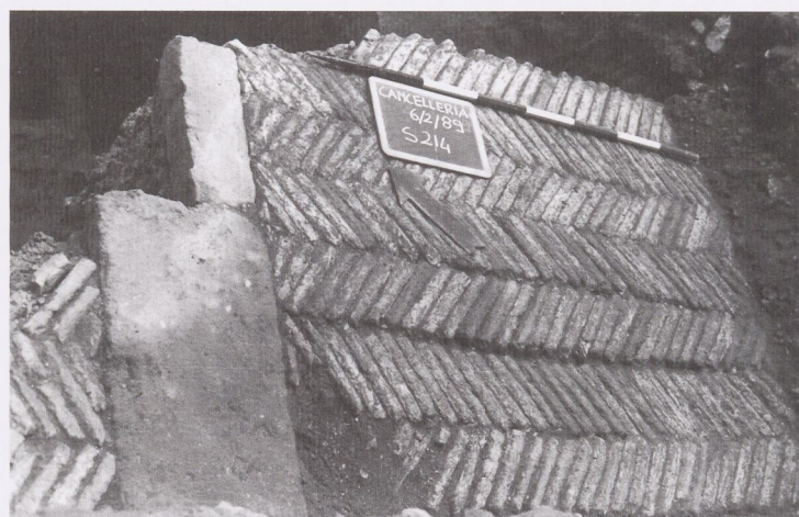
Fig. 17. Palazzo della Cancelleria, resti del pavimento del Cortile (foto M. Pentiricci).
