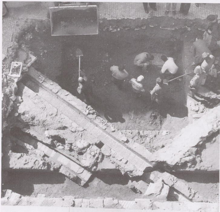
Fig. 4. Palazzo della Cancelleria - Cortile. Nell'immagine è visibile il vecchio sistema di deflusso delle acque del Palazzo; al di sotto si intravedono le poderose murature in tufo (Bibl. Hertz. D 30528).
