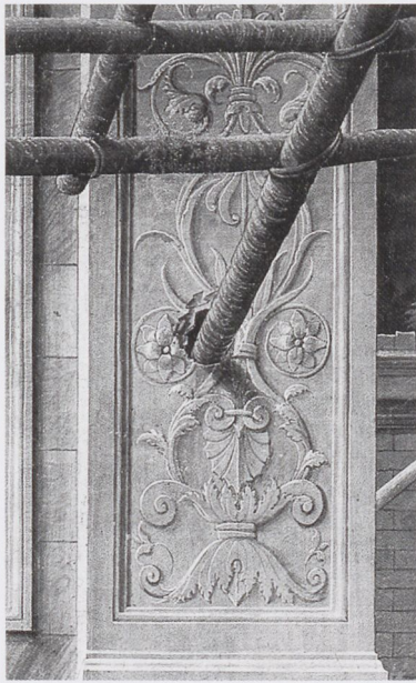
10 Verankerung eines Lauben-Balkens in der Palastwand. (Ausschnitt aus Abb. 2)
