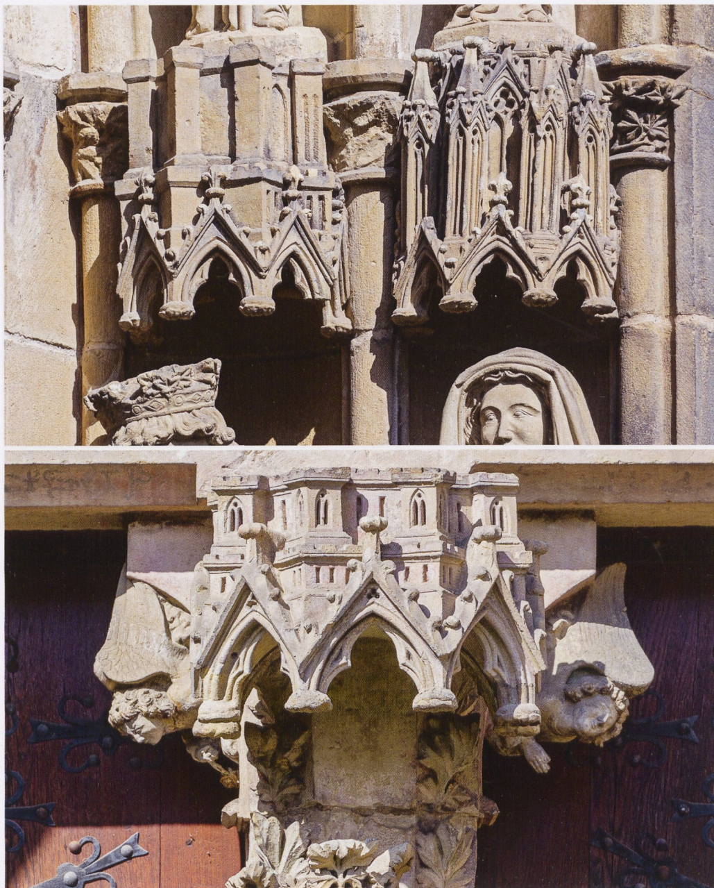
Abb. 16 und 17 Baldachine am Südportal
