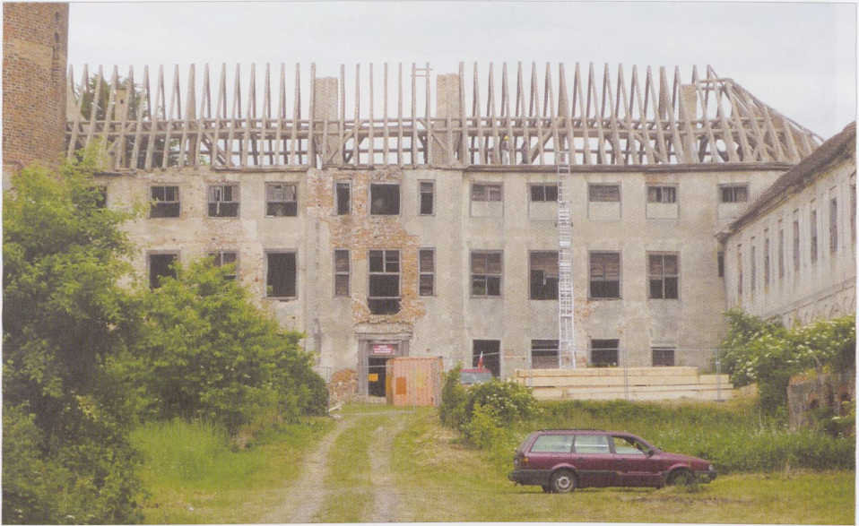
Abb. 13: Schloss Wildenbruch (Swobnica), Corps de Logis mit abgedeckten Ziegeln und sichtbarem barockem Dachstuhl während der Wiederherstellung des Dachs, Juni 2012
