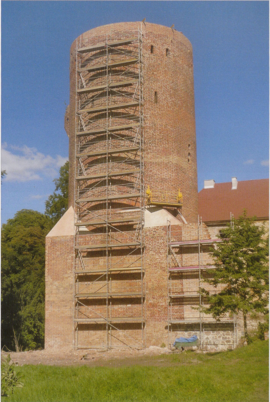
Abb. 15: Schloss Wildenbruch (Swobnica), Bergfried während der Restaurierungsarbeiten, August 2013
