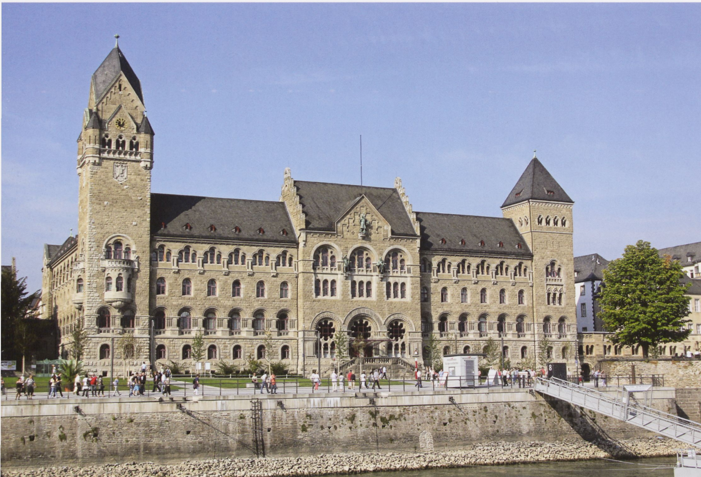
Abb. 10: Paul Kieschke, ehemaliges preußisches Regierungsgebäude in Koblenz, 1902 – 1906.
