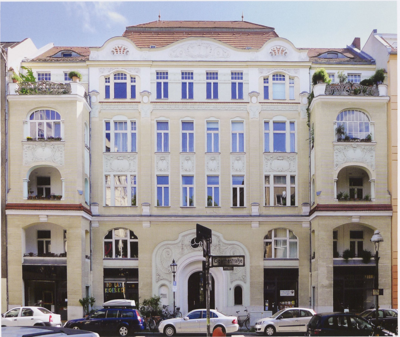
Abb. 18: Curt und Arthur Reimer, Mietshaus Goethe-, Ecke Herderstraße in Berlin-Charlottenburg, 1902/1903.
