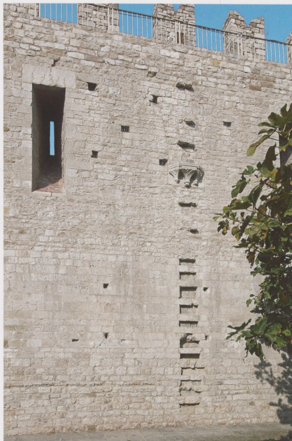
11 Prato, vorgesehene Wandverzahnung und Dreierkonsole an der Position E. Die Befunde widersprechen sich, denn die Wand hätte die Mittelkonsole für einen Gurtbogen überflüssig gemacht. Offenbar liegt hier ein Planwechsel vor: Die ursprünglich vorgesehene Wand wurde zugunsten eines Gurtbogens, d. h. eines zweijochigen Raumes, aufgegeben, das Ausmauern der Verzahnungslöcher bzw. das Abschlagen der Wartesteine fand wegen der Einstellung des Baues nicht mehr statt. – Foto: Thomas Biller, 2017.
