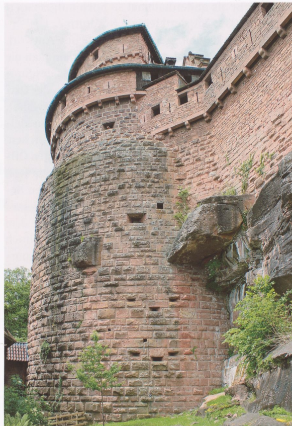
Abb. 10 Hohkönigsburg, der Südturm des „Großen Bollwerks“ von Osten. Unten zwei Dreiergruppen von Gewehrscharten, darüber, auf Höhe der vorspringenden Felsen eine Geschützscharte und ein quadratisches kleines Fenster, daneben am Mauerknick ein Bogenansatz. In diesem Bereich lag das aufgegebene Tor mit Fußgängerpforte (vgl. Abb. 11).
