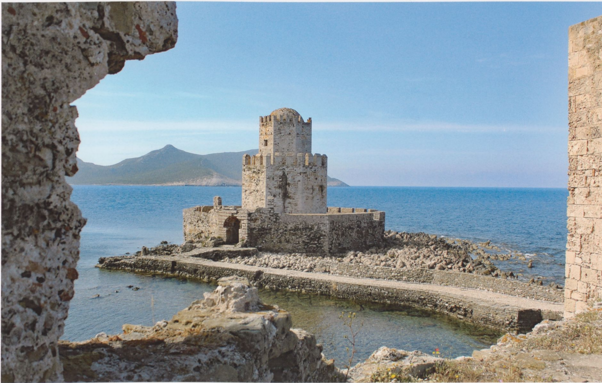
Abb. 7 Methoni/Modon, das venezianische Bollwerk mit dem Kavalier an der Angriffsseite, spätes 15. Jh. (oben), und der osmanische Turm „Bourtzi“ an der Hafeneinfahrt, nach 1498. Das Tor zur Ummauerung des „Bourtzi“ zeigt jene Streifen aus Kalksteinquadern und wiederverwendeten Backsteinen, die in der Regel als byzantinisch gelten.
