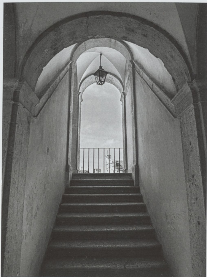
Fig. 27 - Scale che salgono alla loggia della facciata ovest (foto di N. Federici).
