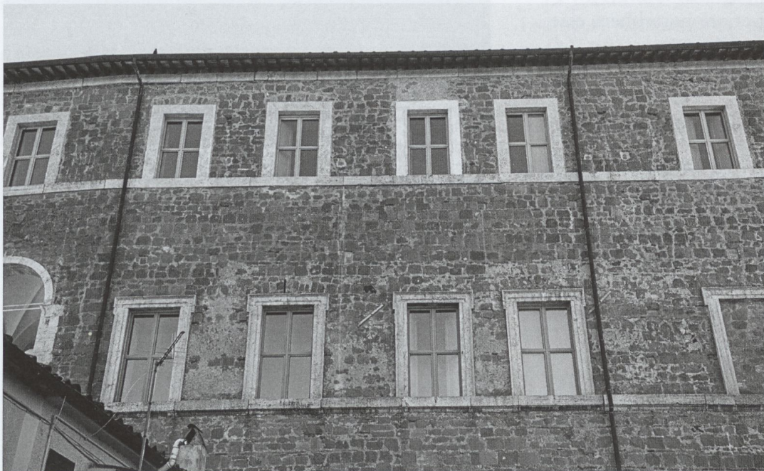
Fig. 10 - Murature differenti sul fronte nord (foto di N. Federici).
