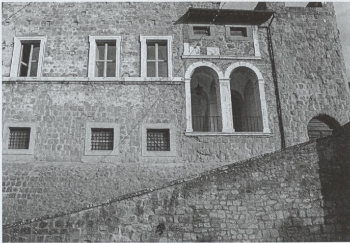
Fig. 8 - Murature della scarpa e della rampa (foto di N. Federici).
