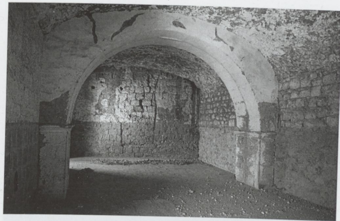
Fig. 6 - Sala al piano terreno con volta a botte e arcone di sostegno (foto di N. Federici).
