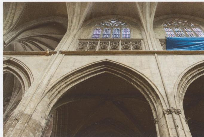
Fig. 2. Toulouse, cathédrale, arcades ouest, côté nord. Le renforcement du pilier à gauche (B1nord) est bien visible © C. Freigang
