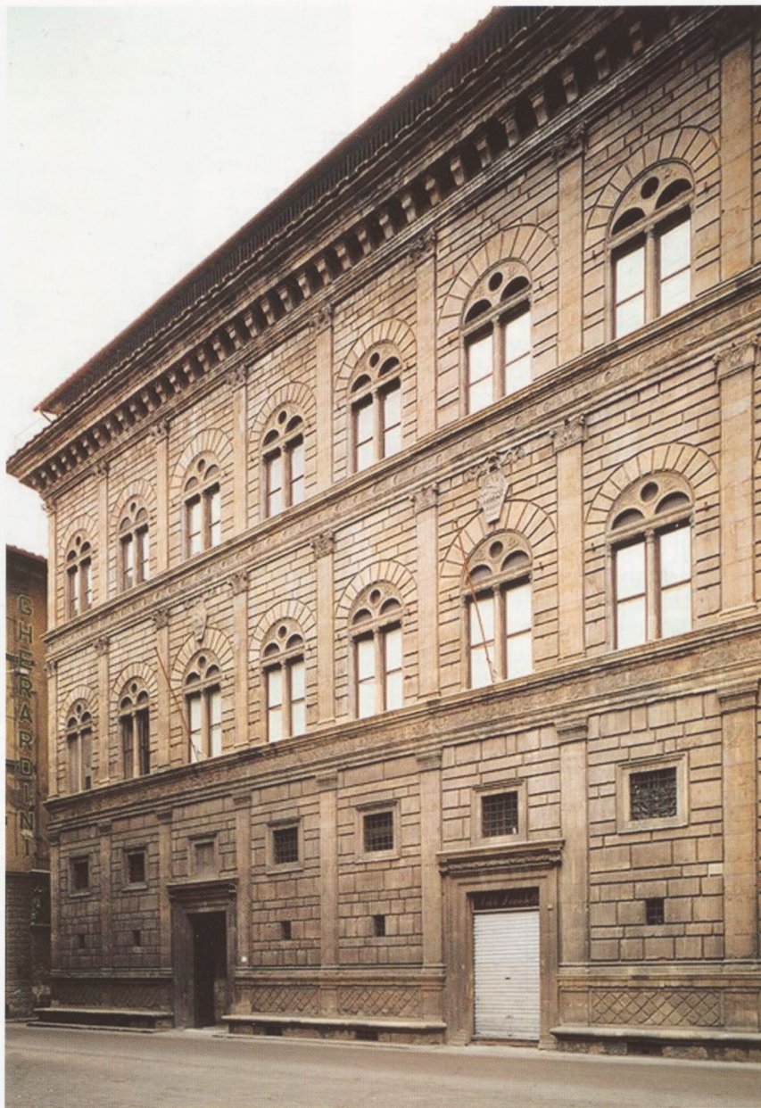
7 – FIRENZE, PALAZZO RUCELLAI (foto Archivio del Bollettino d'Arte)
