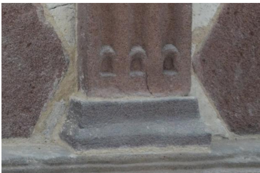
Abb. 52 Basis und Ansatz des Schaftes eines Pilasters auf der Ostfassade der Torhalle
