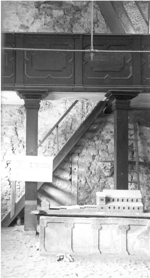
Abb. 2 Lorsch, Torhalle, Nordwand Innenseite zu Beginn der Restaurierungsarbeiten 1934/35
