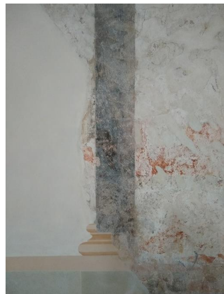
Abb. 13 Lorsch, Torhalle, Obergeschoss Ergänzung einer gemalten Säule auf der Nordwand in trateggio-Technik
