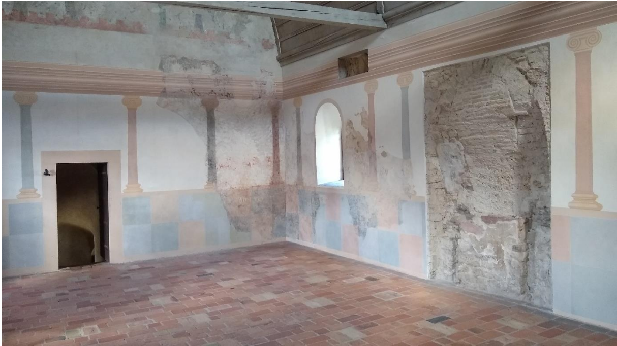
Abb. 10 Lorsch, Torhalle, Obergeschoss, Blick in die nordöstliche Ecke nach Abschluss der Konservierungs- und Restaurierungsarbeiten, 2024
