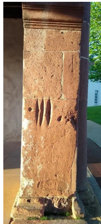
Abb. 41 Lorsch, Torhalle, EG Pfeiler der Westfassade
