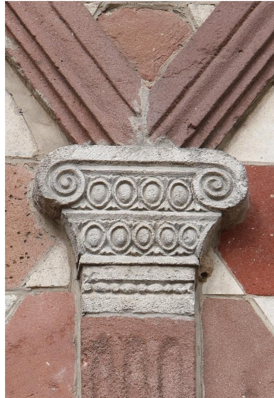
Abb. 57 Schaft und ionisierendes Kapitell eines Pilasters der Fassade der Torhalle
