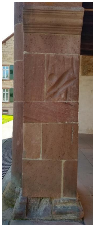
Abb. 40 Lorsch, Torhalle, EG Pfeiler der Ostfassade
