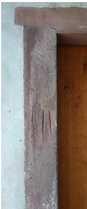
Abb. 39 Lorsch, Torhalle, EG Türgewände Nordseite
