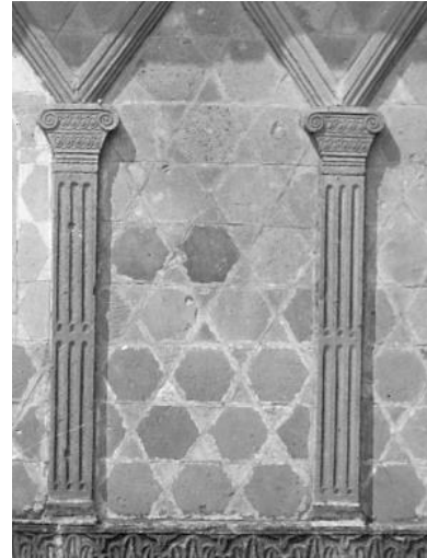
Abb. 49 Die Pilaster im Obergeschoss der Torhalle
