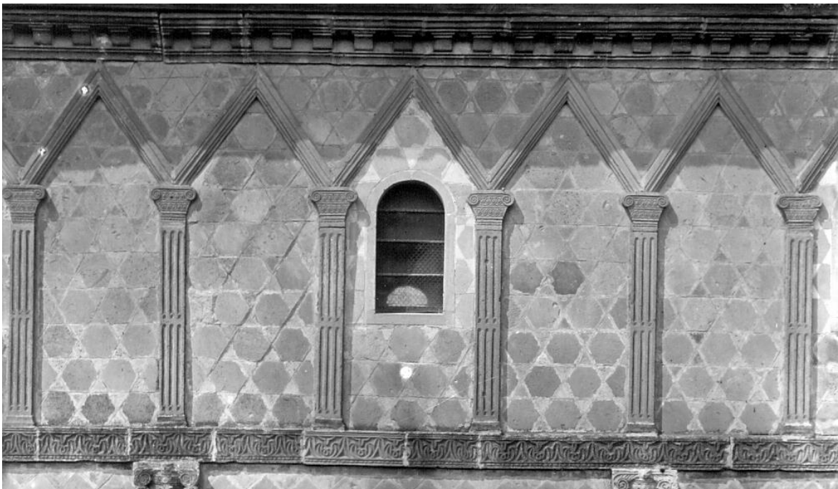
Abb. 46 Die Pilastergliederung im Obergeschoss der Torhalle, Ostfassade Mittelteil
