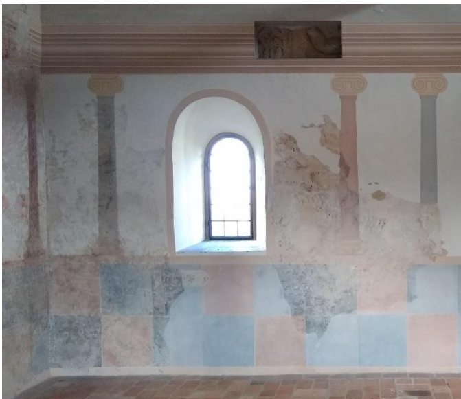
Abb. 12 Lorsch, Torhalle, Obergeschoss Ostwand, nördliche Hälfte, konservierte und restaurierte Wandmalerei
