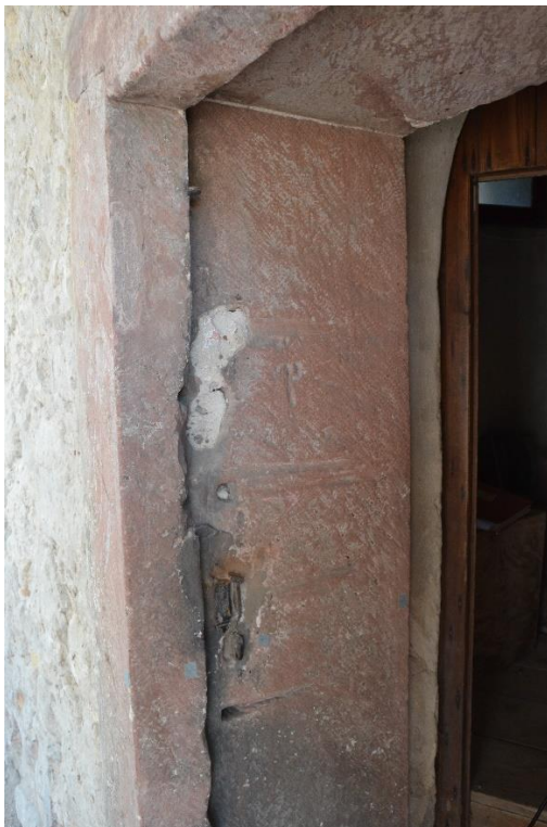
Abb. 20 Lorsch, Torhalle, Erdgeschoss Südwand, östliches Türgewände
