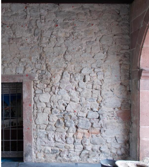
Abb. 14 Lorsch, Torhalle, Erdgeschoss Mauerwerk der Südwand
