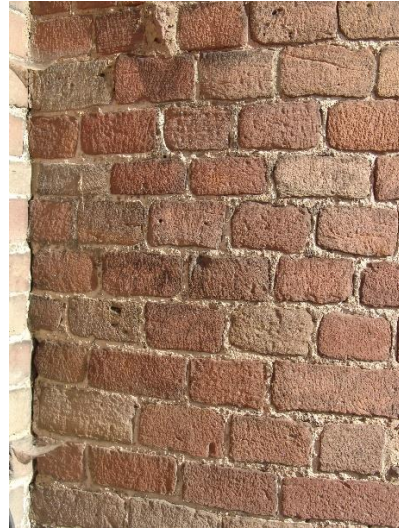
Abb. 11 Michelstadt-Steinbach Einhardsbasilika, Apsis, Mauerwerk
