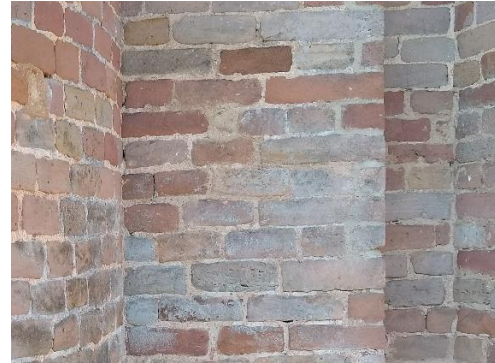
Abb. 13 Michelstadt-Steinbach Einhardsbasilika, Apsis, Mauerwerk
