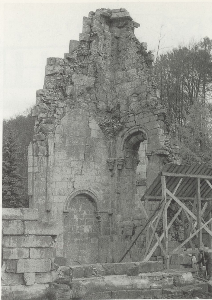
16. Walkenried. Zungenmauer und ehem. Ostfenster. Davor teilweise abgetragene Südwand 1986
