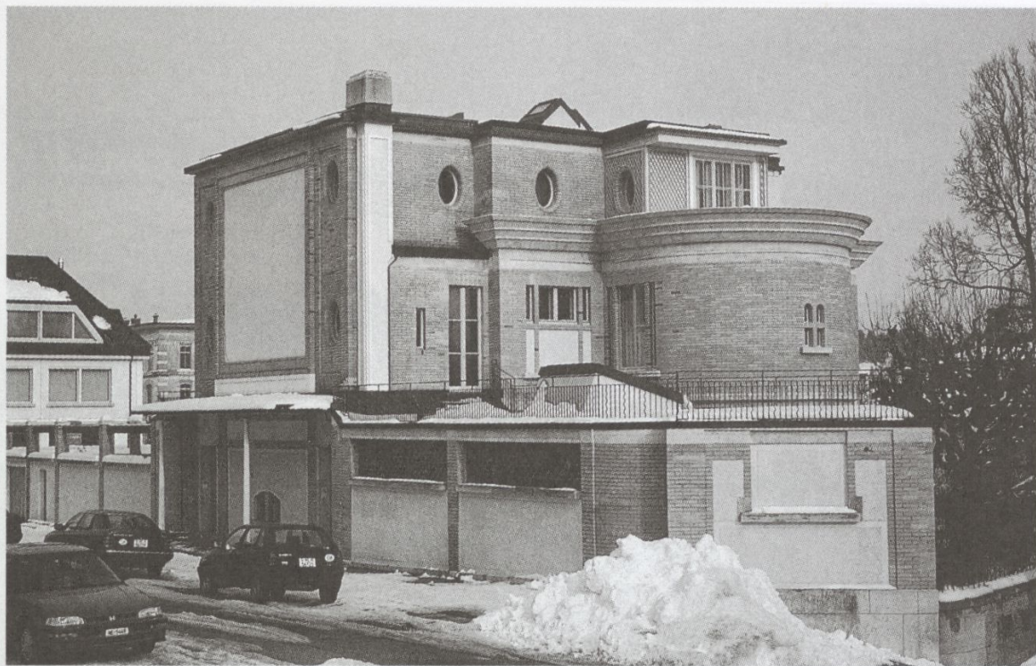
Abb. 7 Charles-Edouard Jeanneret (Le Corbusier), Villa Schwob, La Chaux-de-Fonds, 1915/16, Gesamtansicht (Foto: Verfasser)
