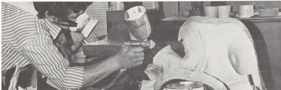
Vorbereitungsarbeiten und Einspritzen der gefärbten Feinschicht in die Teilformen.
