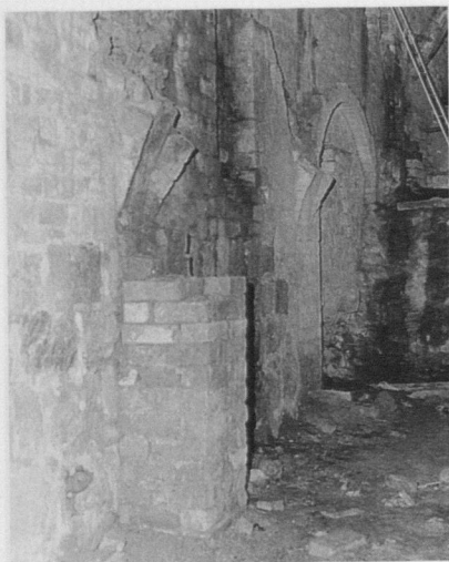
◀ 61 Chorin, Westflügel der Klausur, Westwand des Kellerraumes K 5 gegen Norden. Hinten, im 4. Joch von Süden, das vermauerte Westportal zum Cellarium, daneben Reste der Schuttfüllung des Kellers. Vor dem Cellarium zwei Ansätze der Rippenwölbung, dazwischen ein vermauertes Kellerfenster, oben Schildbögen der Kellerwölbung. Unter dem vorderen Gewölbeansatz Rest einer sekundären Abstützung.
