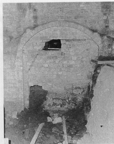
◀ 61 Chorin, Westflügel der Klausur, Westwand des Kellerraumes K 5 gegen Norden. Hinten, im 4. Joch von Süden, das vermauerte Westportal zum Cellarium, daneben Reste der Schuttfüllung des Kellers. Vor dem Cellarium zwei Ansätze der Rippenwölbung, dazwischen ein vermauertes Kellerfenster, oben Schildbögen der Kellerwölbung. Unter dem vorderen Gewölbeansatz Rest einer sekundären Abstützung.
