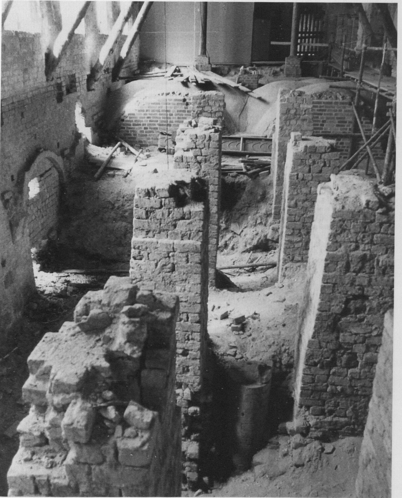
60 Chorin, Westflügel der Klausur. Blick in das ehemalige Cellarium (K 5) von Süden, Zustand nach Teilfreilegung im Juli 1994. Zwischen den beiden Reihen von Stützenfundamenten des späten 18. Jahrhunderts vorne der Stumpf einer originalen Säule. Hinten die neuen Gewölbe des Raumes K 7 (1974), darüber zwei Holzstützen des Erdgeschosses (1954).
