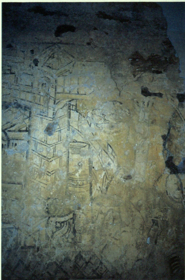
Abb. 1. Stadtdarstellung des späten 12. Jahrhunderts an der Nordwestwand des (ehem.) 2. Obergeschosses (Ausschnitt; Foto: C. Kosch).
