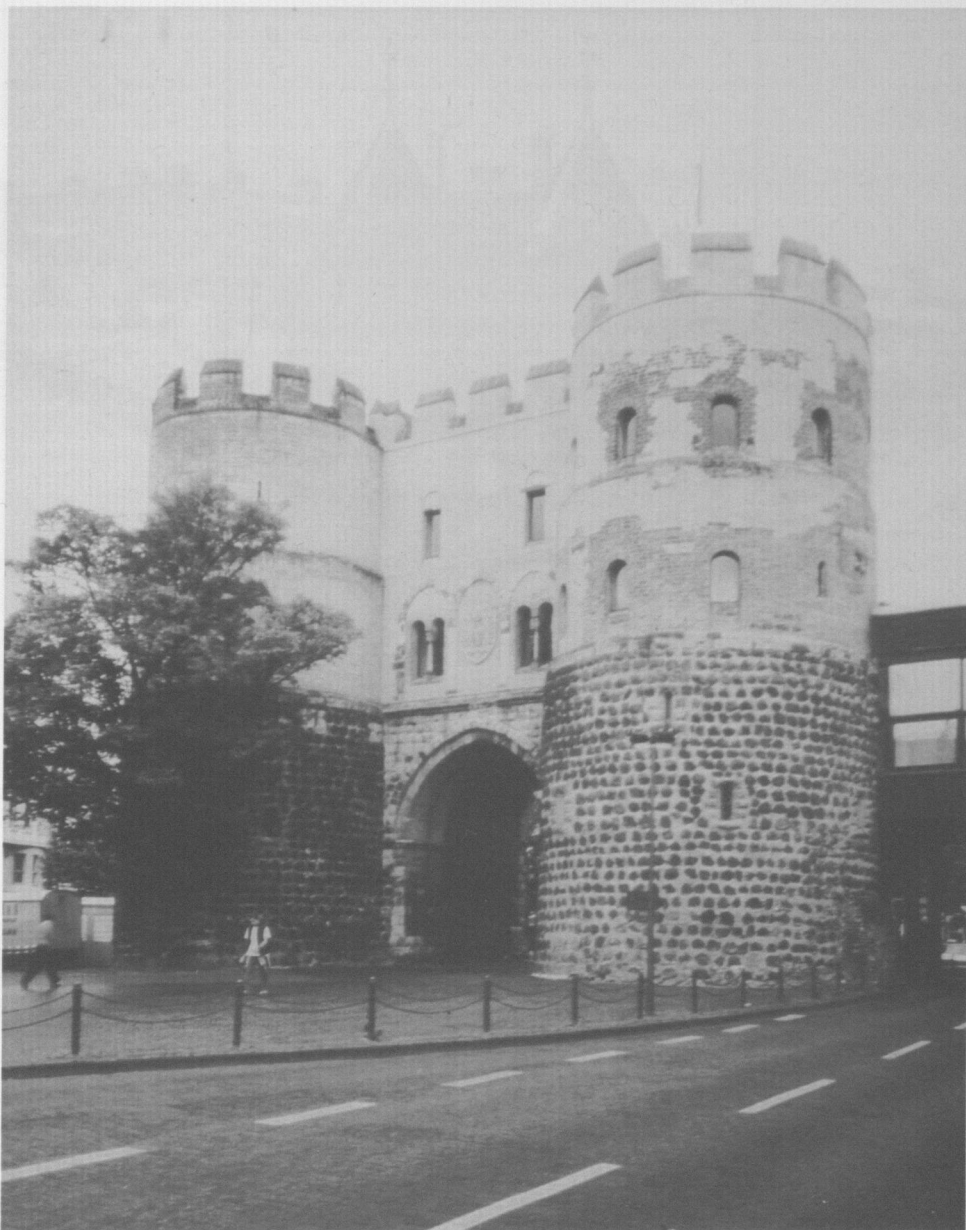
Abb. 2. Köln (Nordrhein-Westfalen), "Hahnenort". Eines der beiden erhaltenen, stark restaurierten Kölner Doppelturmtore, die ab etwa 1200 entstanden und zu Vorbildern zahlreicher Stadttore des Rheinlandes wurden.
