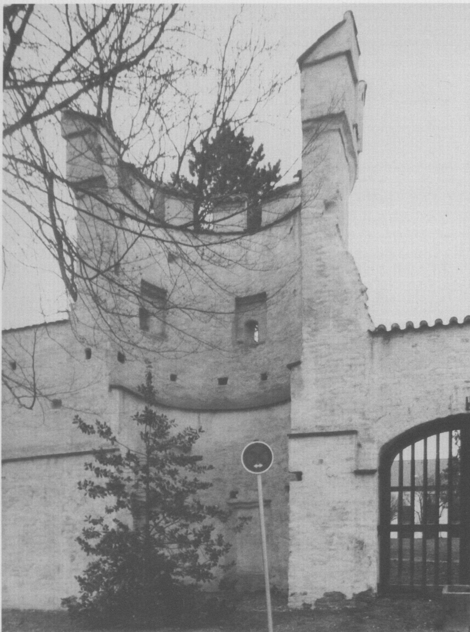
Abb. 17. Landsberg am Lech (Bayern), Schalenturm der Oberstadt. Analog zum gleichzeitigen "Bayertor" (Abb. 16) zeigen die geringe Mauerstärke des Turmes und die Beschränkung auf Scharn für Hakenbüchsen, daß schwere Geschütze hier noch nicht ins Kalkül gezogen waren. (Th. Biller)
