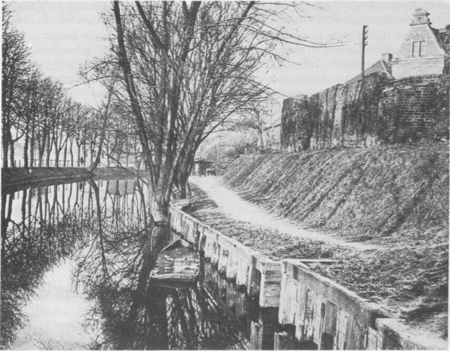
Abb. 19: „Mühlgraben“ und Stadtmauer im Bereich des heutigen Viktoriaufers um 1898, im Hintergrund ein Giebel des alten Postgebäudes. Schießscharten und Anschüttung gehörten zu der Modernisierung der Befestigung im 19. Jh.; um 1900 abgerissen (H. W. Klünner: Spandau wie es war, Düsseldorf 1978).
