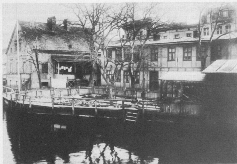
Abb. 3: Schleusenmeisterhaus (1846) und Fachwerkseitenflügel an der Stadtmauer (1867) im Zustand von 1911. Die Fassadengliederung des Schleusenmeisterhauses (links) ist wesentlich vollständiger erhalten als beim Abbruch 1981 und in der z. Z. bestehenden Planung (Archiv A. Kalesse, Spandau).
