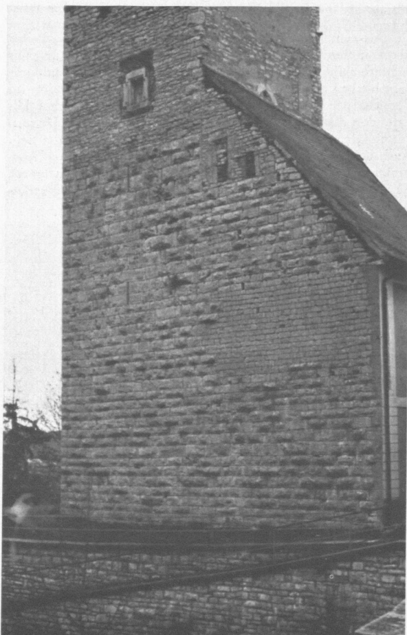
Abb. 6 Hirschberg, romanischer Teil des Bergfrieds und Rest der Schildmauer. An der Westseite des Turmes sind die erste und zweite Obergeschoß führenden Lichtschlitze zu erkennen. Der rechts in gleicher Flucht anschließende Rest der Schildmauer ist durch den zweimaligen Wechsel der Mauer technik bemerkenswert
