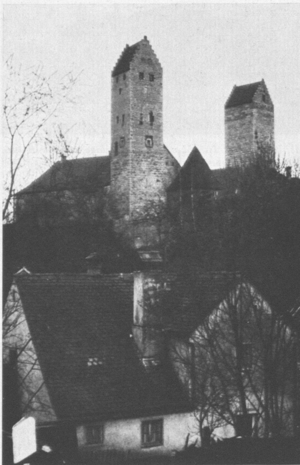
Abb. 4 Hirschberg, Bergfried (vorne) und Torturm von Nordwesten. Der Bergfried ist nur bis zu halber Höhe romanisch. Das links anstoßende Gebäude ist barock auf gotischer Grundlage, benutzt aber die in beträchtlicher Höhe erhaltene romanische Ringmauer. Rechts vor dem Bergfried ein Flankierungsturm der spätgotischen Vorburg
