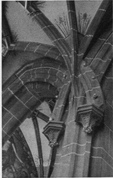
2. Gewölbeansatz in der Nordkapelle der Pfarrkirche von Wimpfen am Berg, Wimpfen, Rippen.
