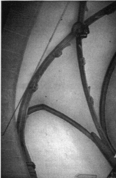
7. Gewölbe der Empore des Westchors im Doms von Eichstätt.
