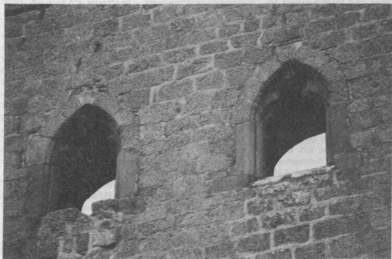
Abb. 5: Hohandlau bei Andlau. Wohnbau, Ostwand, 1. Obergeschoß, Fenster (wohl um 1250–60). (Foto Th. Biller, 1983)
