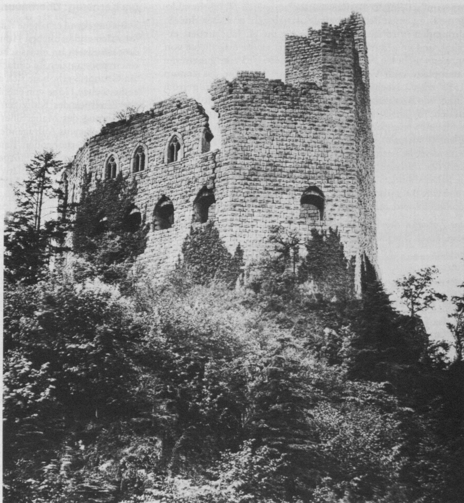
Abb. 1. Spesburg, die Kernburg von Nordosten, Mitte 19. Jh. Der Riß über dem rechten oberen Fenster ist später geschlossen worden, die Brustwehrreste sind heute geringer, sonst ist der Zustand kaum verändert (vgl. Abb. 9); die Vorburgreste liegen unter dem Gebüsch links (heute stehen dort hohe Bäume). (A. Braun, L'Alsace photographiée, Mulhouse 1859).
