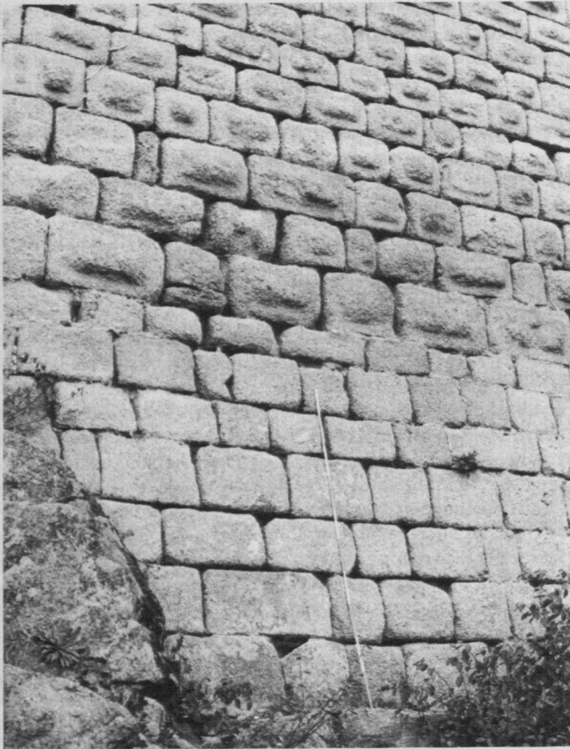
Abb. 4. Spesburg, Granitbuckelquader und glatt gequaderter Schrägsockel der Kernburg, nahe der Südspitze; der Zollstock ist 2 m lang (Th. B. 1971)
