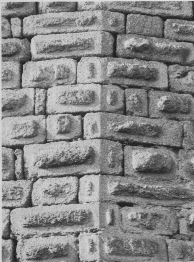
Abb. 5. Spesburg, Eckausbildung der Kernburg nahe der Südspitze; der grobkörnige Granit ist vor allem an den „brotlaibförmigen“ Buckeln schon verwittert (Th. B. 1971).
