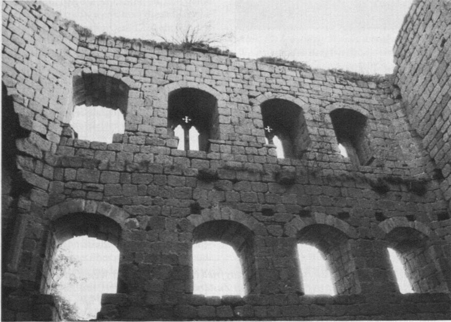
Abb. 15. Spesburg, Ostwand des Ostflügels innen; oben die Fenster des Saales, darunter gehören die drei seitensitzlosen Fensterischen zu einem Raum, links lag jenseits der verschwundenen Trennwand ein zweiter (vgl. Abb. 14) mit Kamin und Seitensitzen (Th. B. 1971).
