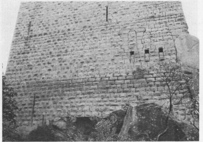
Abb. 11. Spesburg, die Außenseite (Nordansicht) der Schildmauer, unterer Teil (vgl. Abb. 12). Die Pforte wurde schon in der ursprünglichen Bauzeit zugunsten des Bergfrieds aufgegeben, die Kragsteine darunter abgemeißelt (Th. B. 1971).
