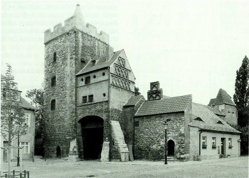
1. Naumburg, Marientor, Ansicht von der Stadt (von Süden; 1996). Rechts neben dem inneren Torbau die Mauertreppe mit Stichbogenpforte und Pultdach, dahinter das »Akzisehaus«.
