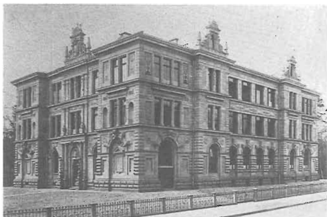
Abb. 29 Kunstgewerbeschule, Karlsruhe Nordostansicht
