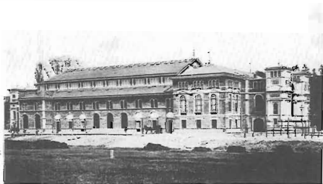
Abb. 53 Festhalle, Karlsruhe, Seitenansicht
