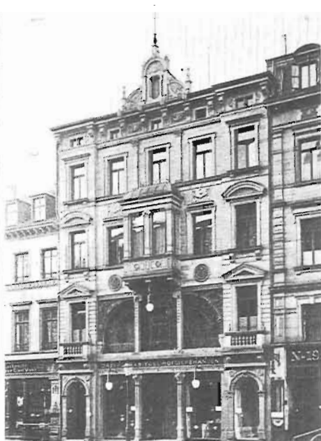
Abb. 21 Haus Dreyfuss, Karlsruhe Umbau von 1907
