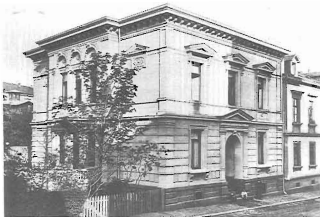
◀ Abb. 1 Wohnhaus Hepp, Pforzheim
