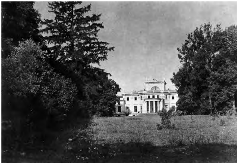
47. Waka, park przed elewacją ogrodową pałacu. Fot. przed 1939, Instytut Sztuki PAN
