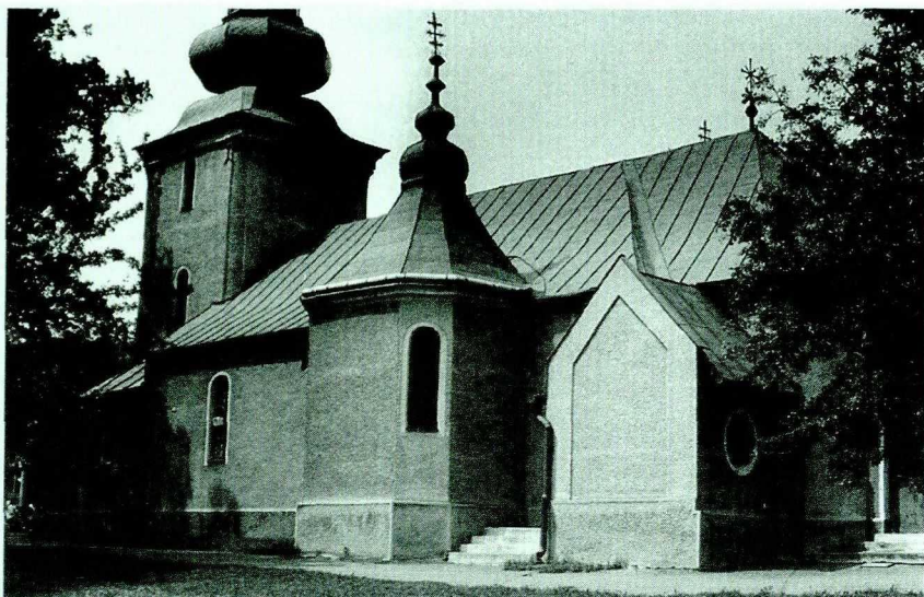
4. Humenne, cerkiew parafialna, widok od strony prezbiterium. 1767. Fot. P. Krasny. Obszerne kryłoso zwieńczone kopułami nadają bryle świątyni malowniczy wygląd / Humenne. The parish Orthodox Church, view from the choir. 1767. Phot. P. Krasny. Extensive wing-apsidoles crowned with domes give a vivid aspect to the church.
