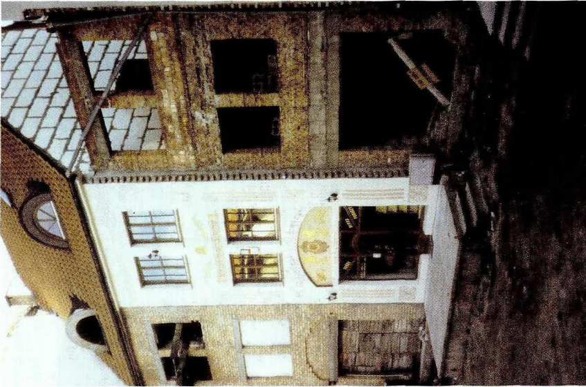
Abb. 4: Elbląg, in typisierender Weise rekonstruiertes Wohnhaus an der Blockkante
