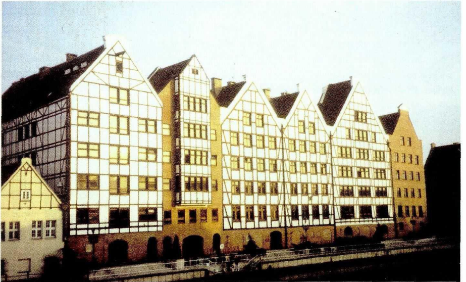
Abb. 13: Gdańsk, Speicherinsel in der Mottlau
