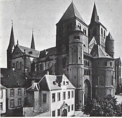
Abb. 5 Trier, Dom, Ansicht von Süd-Westen
