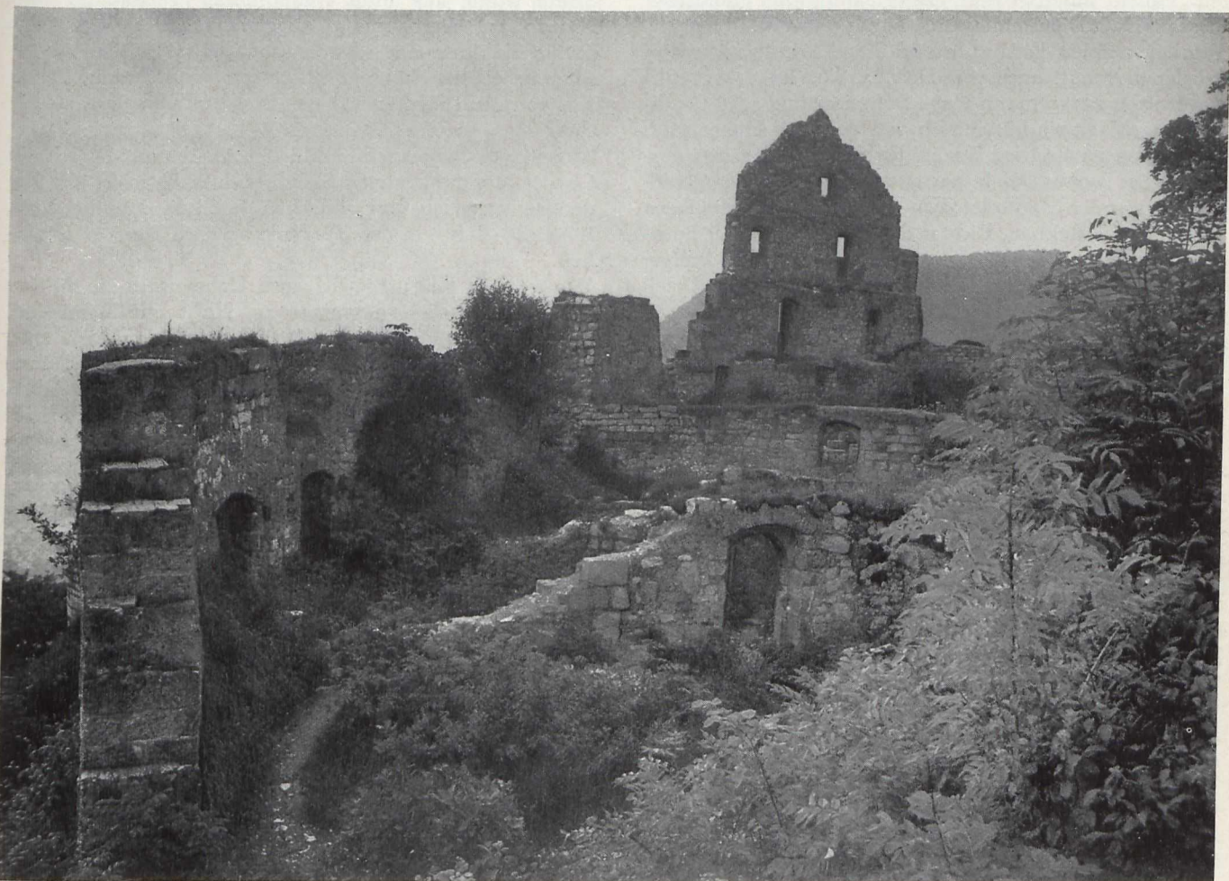
Abb. 5. Hohenurach. Innerer Hof mit Umfassungsmauer, Gebäuderesten und Giebel
