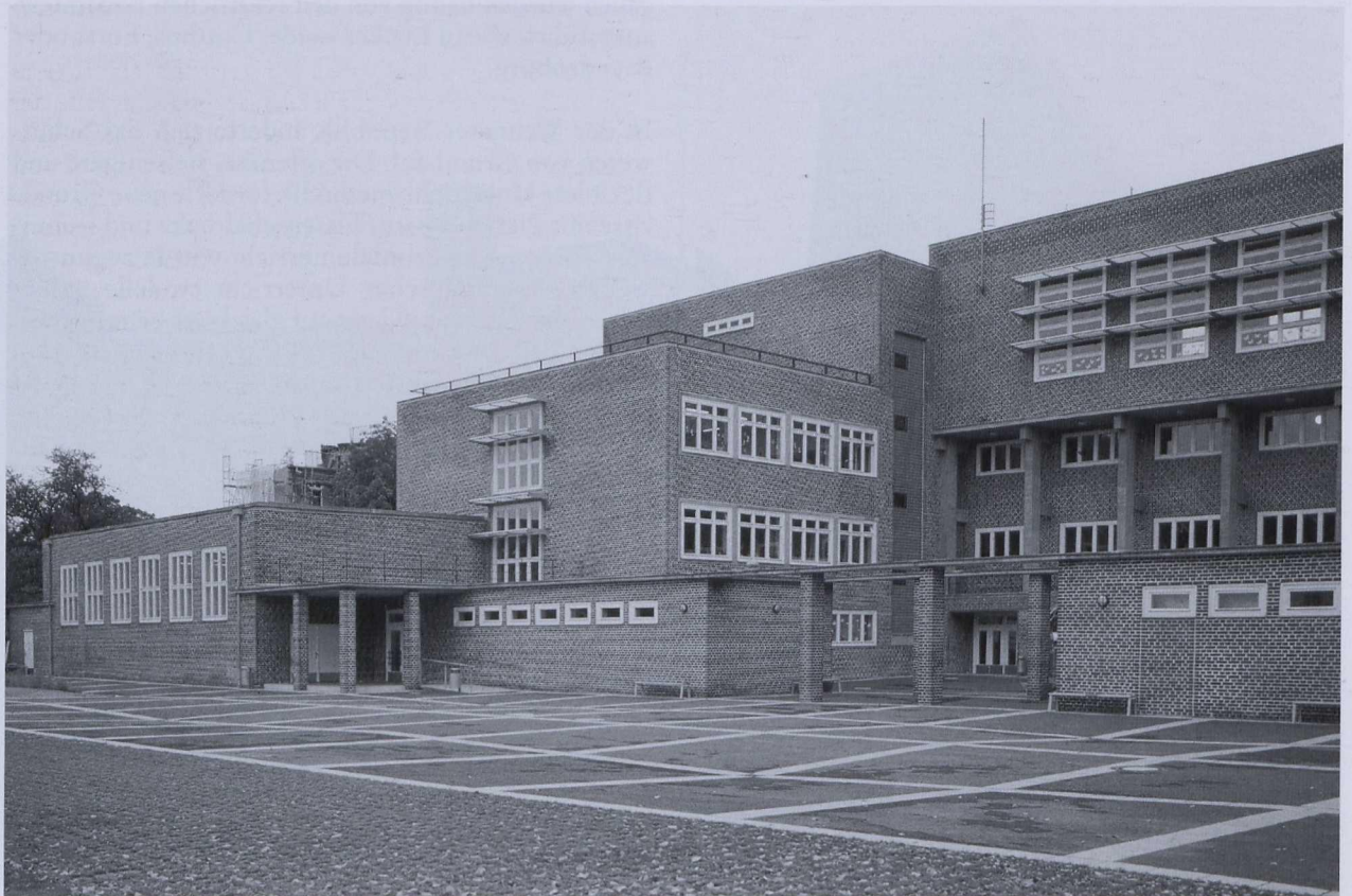
13 Cottbus, ehem. Bismarck-Schule, Hoffassade, 1929-30, Architekt Helmuth Schröder, Aufnahme 1998
