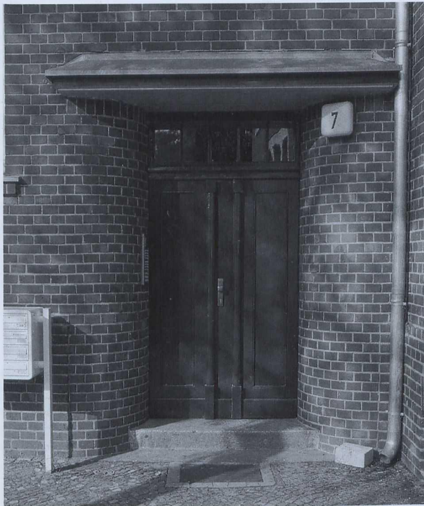
4 Hennigsdorf, Wohnhaus der AEG, Treppenhauseingang, 1911, Architekt Peter Behrens, Aufnahme 1998
