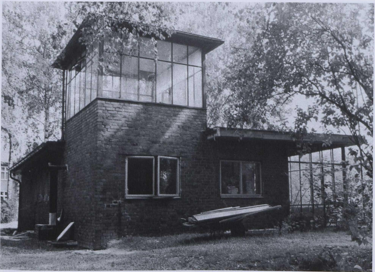
16 Langerwisch, Haus Kopf, Gartenfassade, 1932, Architekt Ernst Danneberg, Aufnahme um 1995
