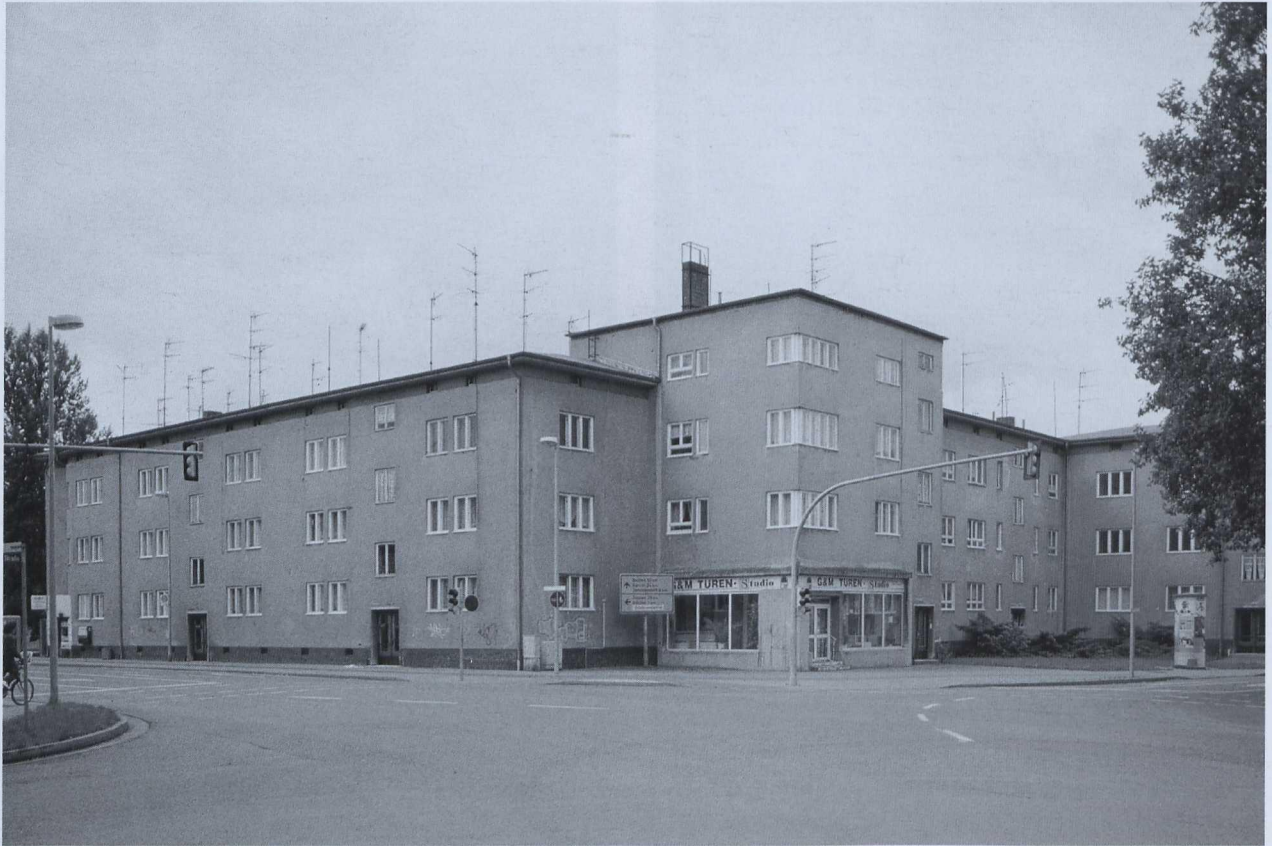
6 Luckenwalde, Volksheimsiedlung, Erweiterung 1930-31, Architekt Willi Ludewig, Aufnahme 1998
