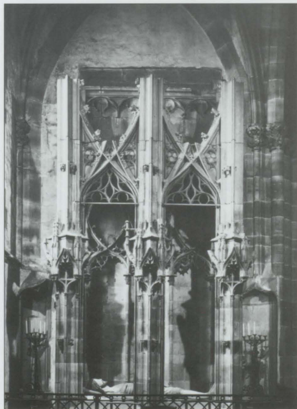
Abb. 6 Weißenburg, ehem. Stiftskirche St. Peter und Paul, Heiliges Grab, Jodokus Dotzinger, 1451/52 (Zustand 1968)
