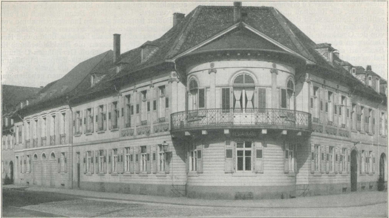
Gesamt-Ansicht des Künstlerhauses in Karlsruhe mit dem linken neuen Anbau.
